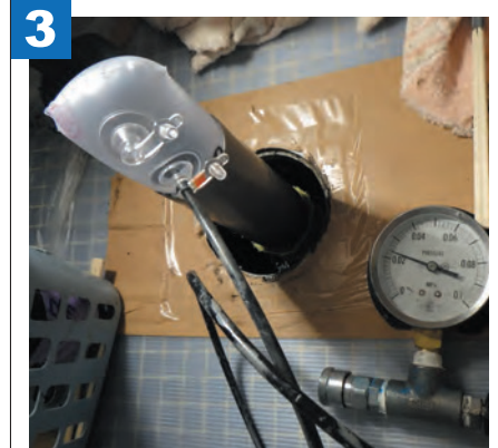
DRトラップ工法によるライニング
