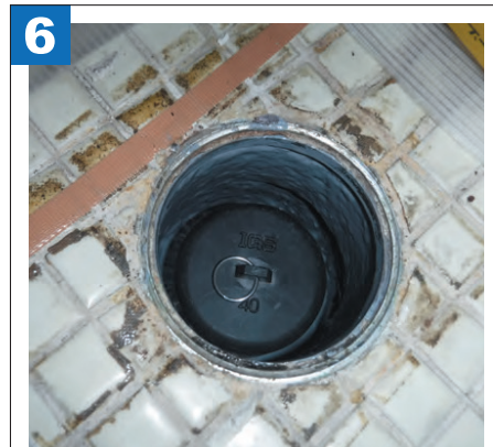
樹脂製のオワン取付け工事完了!!
