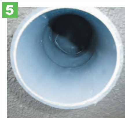
DR工法によりライニング後
