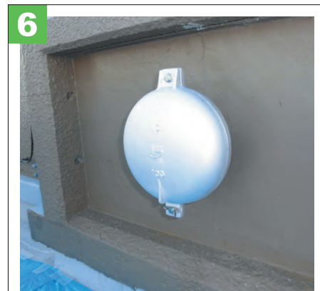
掃除口付ベントキャップを取付け工事完了!!
