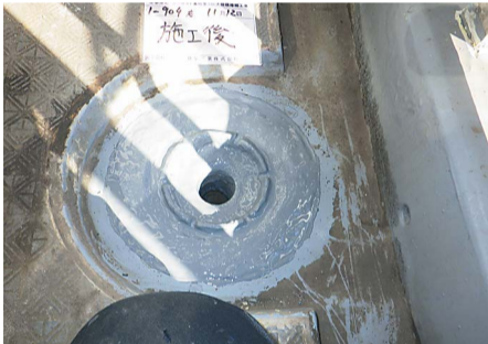
DR工法による施工状況
