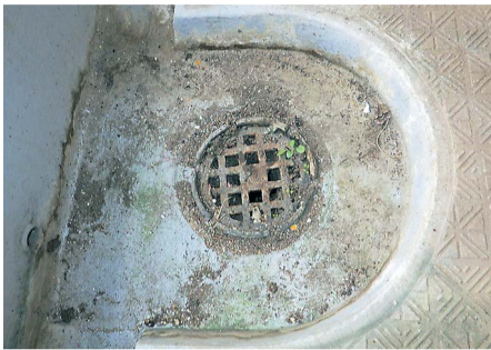
施工前の状況
