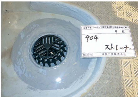
施工後の状況
