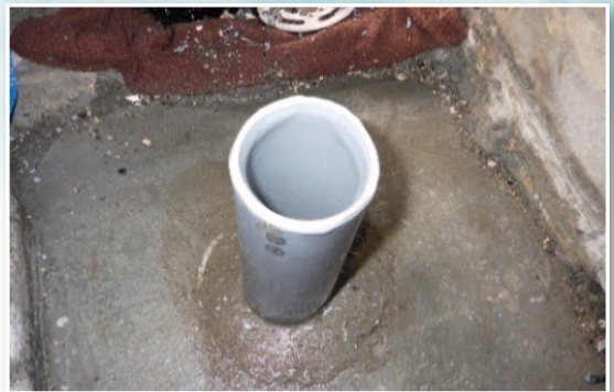
BL-U工法にて配管接続
