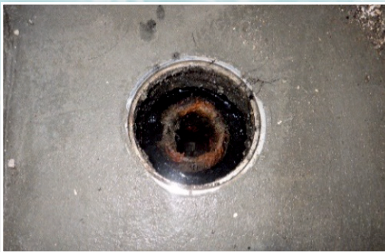
細い塩ビ管をトラップ筒に 差込み、排水している
